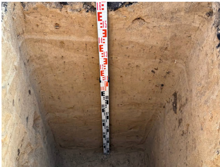
Илл. 15. Нижегородская область, г. Нижний Новгород, Нижегородский р-н, газопровод ввод давлением до 1.2 МПа - 2025 г. Шурф 2. 1 - фотография восточной стенки шурфа. Фото с 3; 2 - фотография нижней части восточной стенки шурфа. Фото с 3; 3 - фотография поверхности шурфа на уровне завершения работ. Фото с Ю.
